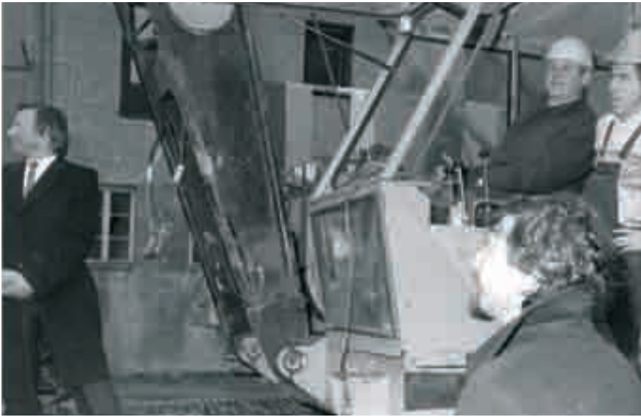
1982: Oberbürgermeister Erich Kiesl beim Spatenstich für Block 50.
